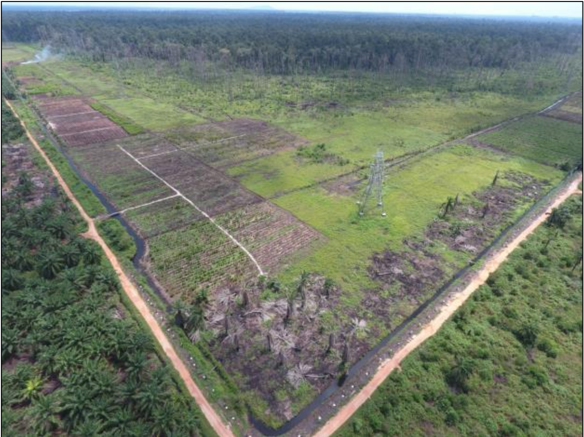
Rajah 2.6 : Aktiviti penerokaan dan pembangunan giat dijalankan di dalam kawasan HSKLS
